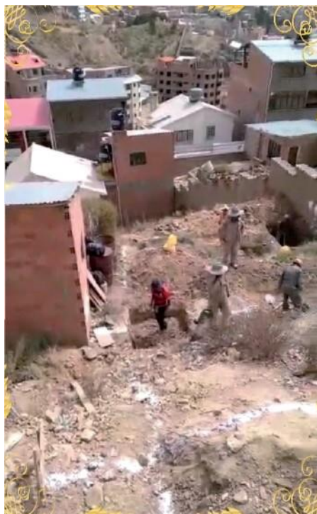
Construcción en área verde
